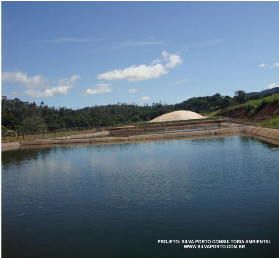
Lagoas de decantação (uma lagoa stand-by para reduzir a retirada de lodo)
