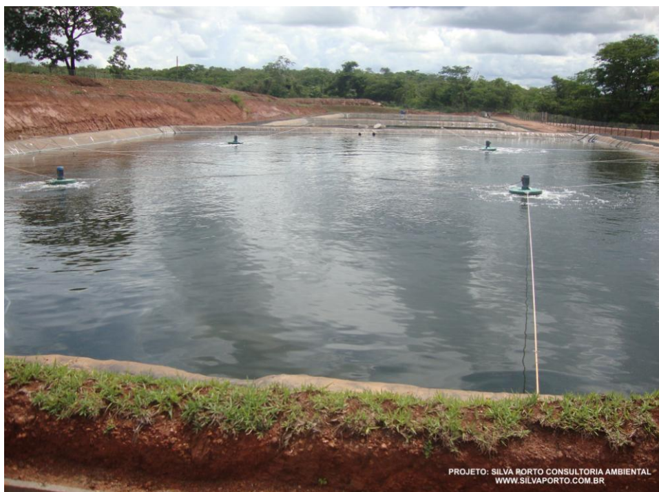
Lagoa aerada mecanicamente
