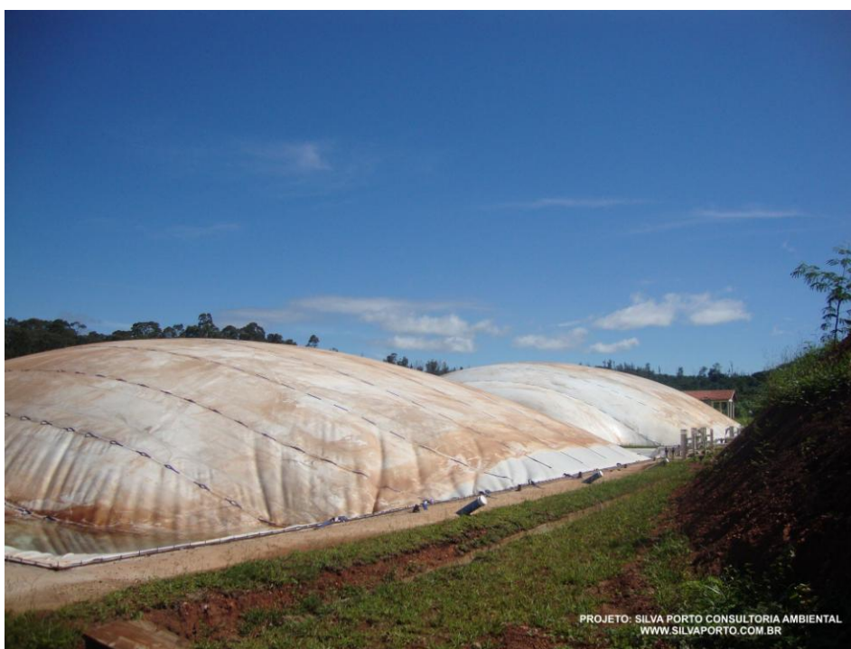
Reatores anaeróbios na forma de lagoas (dois reatores em paralelo)
