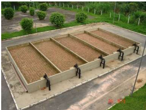
Figura 29: Leito de Secagem
