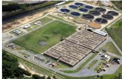
Figura 1: Estação de Tratamento de Esgotos Fonte: Copasa
