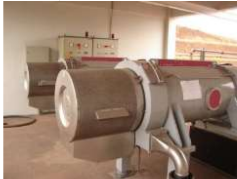
Figura 31: Bomba Centrífuga
