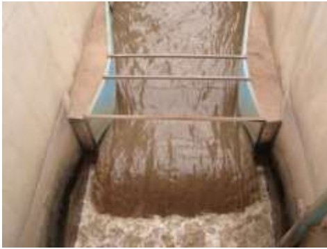
Figura 3: Calha Parshall
