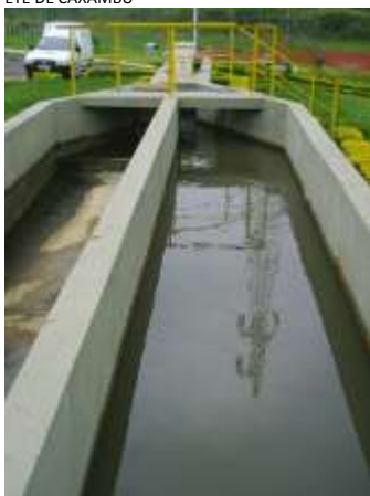
Figura 7: Desarenador em canal
