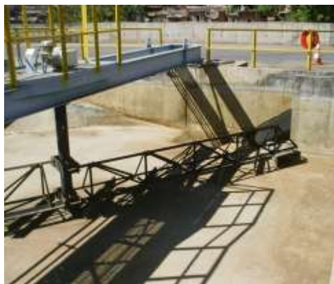
Figura 8: Desarenador mecanizado
