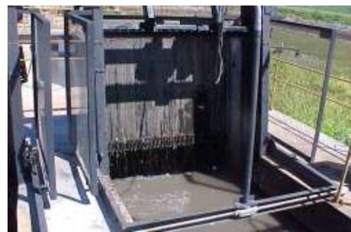
Figura 6: Gradeamento mecanizado
