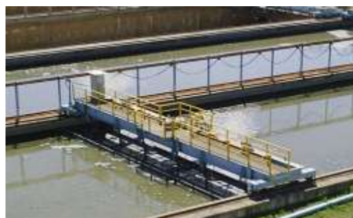
Figura 11: Decantador mecanizado
