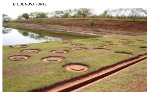
Figura 9: Tanques Imhoff antes da lagoa
