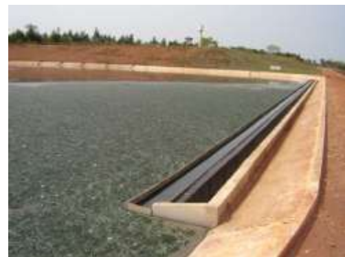
Figura 15: Lagoa Anaeróbia
