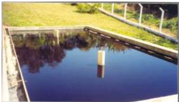
Figura 10: Decantador
