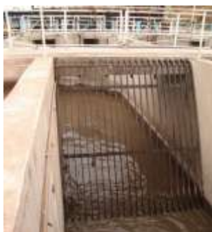
Figura 5: Gradeamento manual
