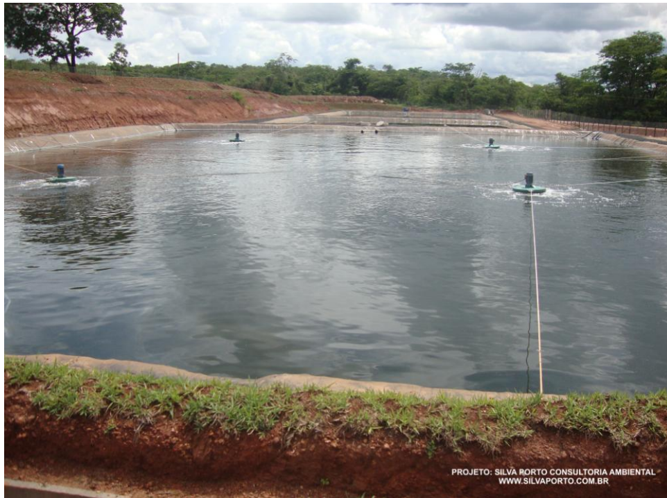
Lagoa aerada mecanicamente
