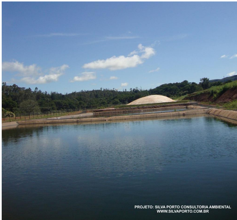
Lagoas de decantação (uma lagoa stand-by para reduzir a retirada de lodo)
