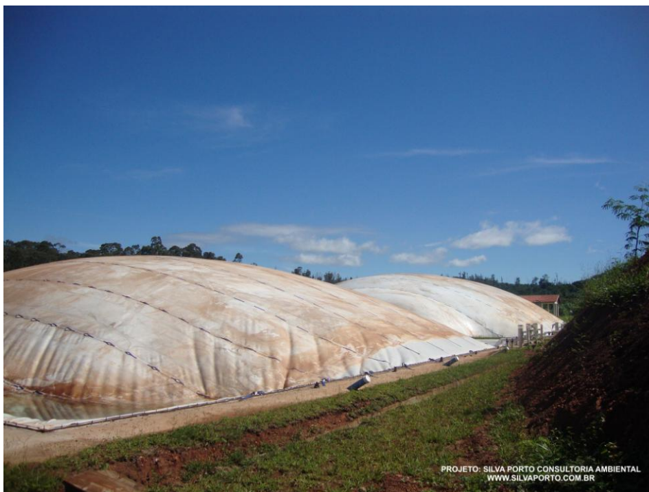
Reatores anaeróbios na forma de lagoas (dois reatores em paralelo)
