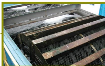
Quando a camada biológica atinge uma espessura excessiva, ela se desgarra dos discos. Parte desses organismos que se desgarram é mantida em suspensão no meio líquido, devido ao movimento dos discos, aumentando a eficiência do sistema.
