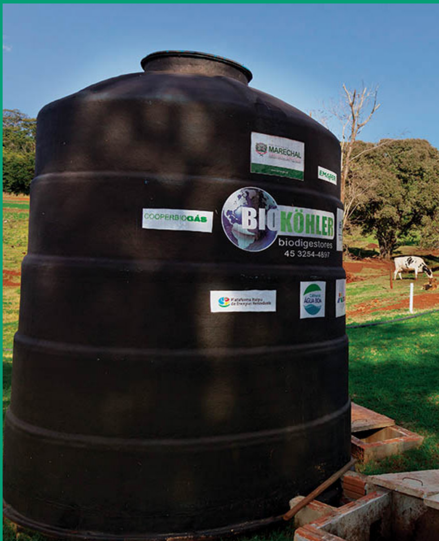
Biodigestor para pequena vazão
