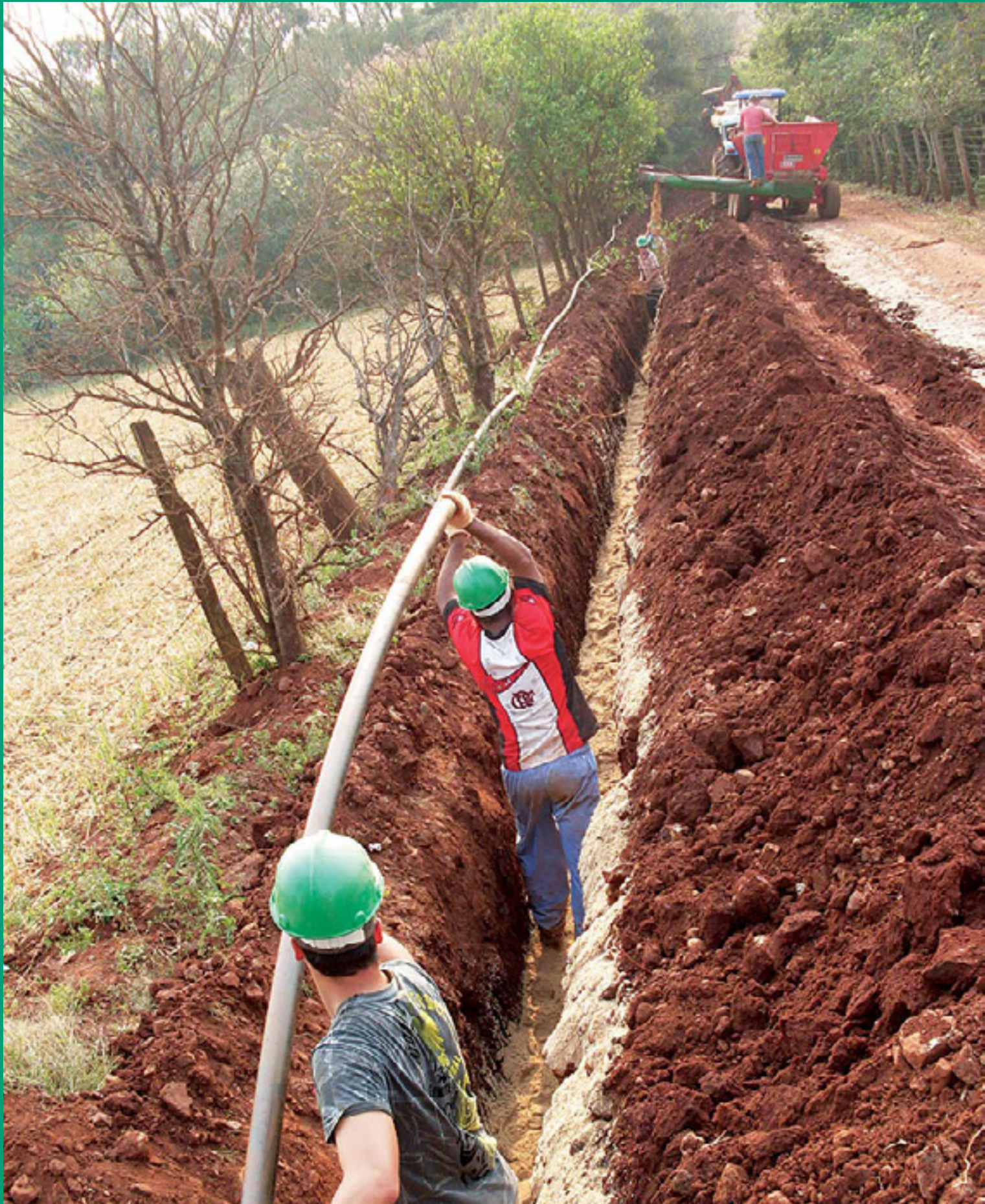
Instalação de gasoduto rural
