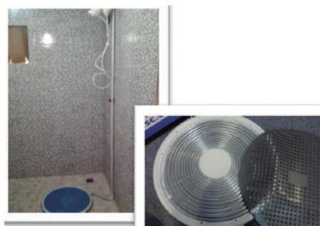
Figura 1 – a) Sistema de Aquecimento Solar em Poste. b) Sistema de trocador de calor para chuveiro.
