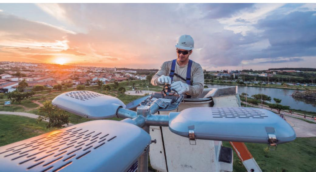
Figura 2 – Luminárias com tecnologia LED.
