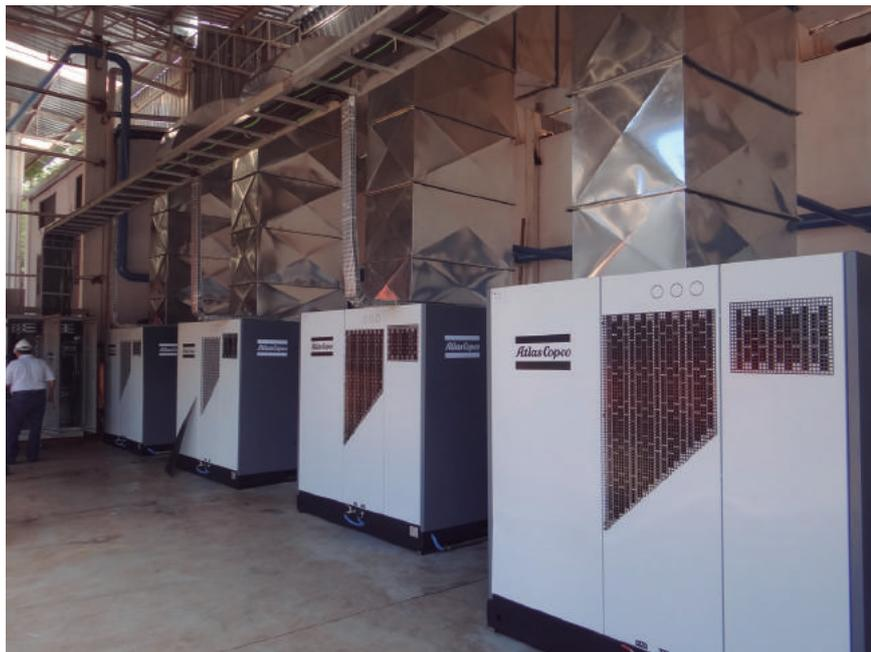
Figura 2 - Compressores instalados.
